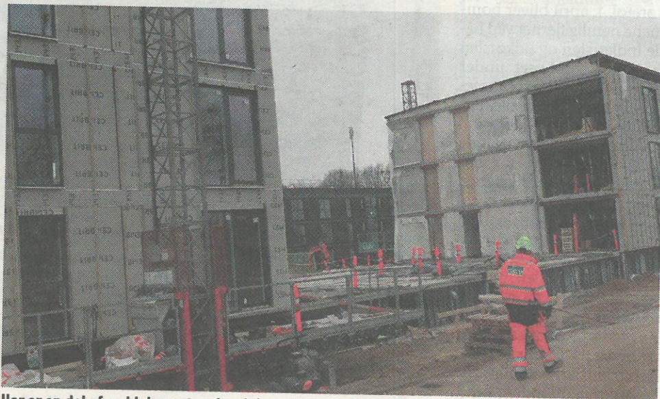
Her er en del af en blok revet ned og bliver til to punkthuse. Foto: Lulu Grønlund
