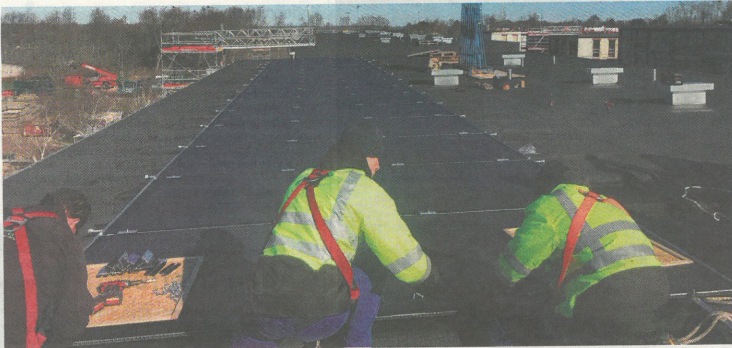
Arbejdet med at lægge solcellerne på tagene i Trige er i fuld gang. Foto: Boligforeningen Ringgården
