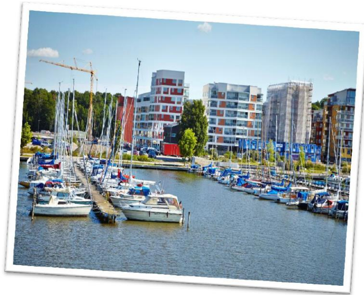
Picture 16 – Råseglet, Öster Mälärstrand, Västerås – Low energy apartment buildings
